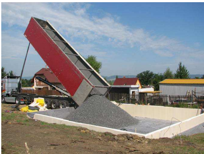
Založení železobetonové desky na drti pěnoskla Technopor.
