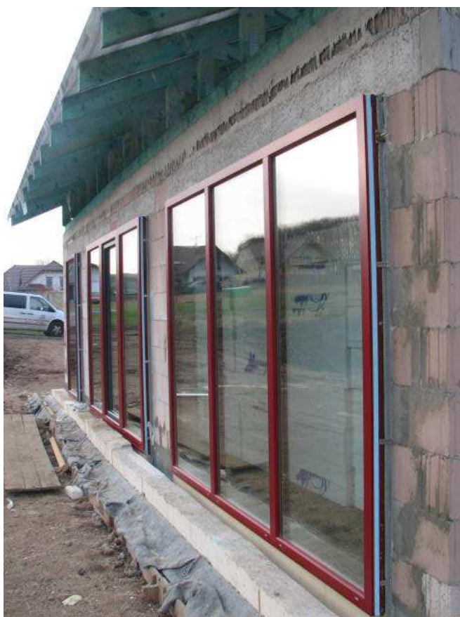
Předsazená montáž oken a příprava na provedení kontaktního zateplení.
