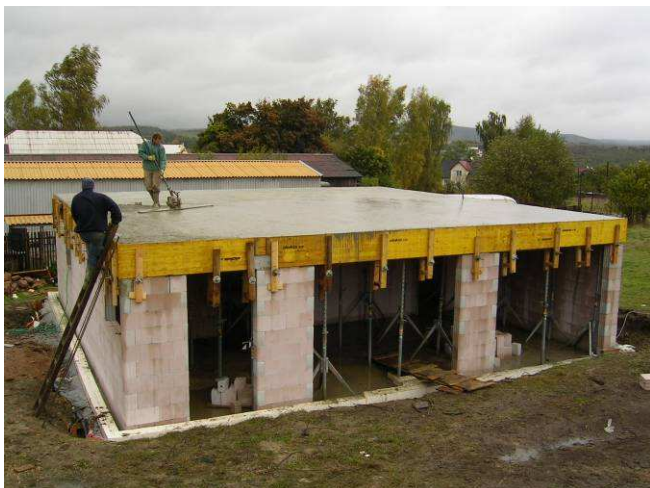
Dokončení hrubé stavby.
