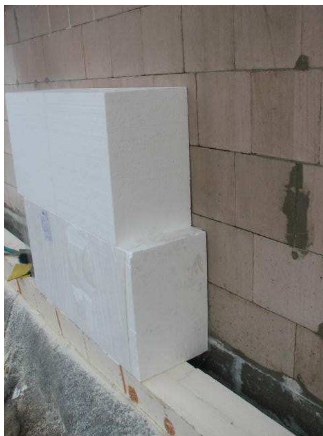
Předsazená montáž oken a příprava na provedení kontaktního zateplení.
