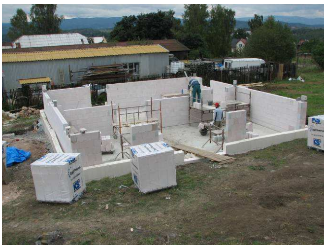
Hrubá stavba z vápenopískových cihel Zapf Daigfuss.
