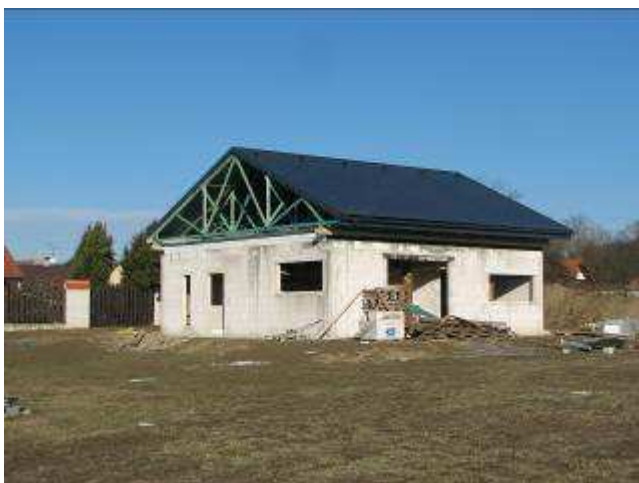
Pasivní dům Plzeň – stavba svépomocí, r. 2010, dosažená vzduchotěsnost n_{50}=0,11 \text{ h}^{-1}
