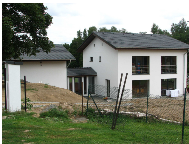
Druhý příklad je pasivní dům Hromnice, r. 2010, dosažená vzduchotěsnost n_{50}=0,13 \text{ h}^{-1} . Dům stavěla menší firma – jejich první zkušenost s pasivními domy i s vápenopískovými cihlami...
